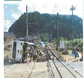
写真1-2-3 令和4年8月の大雨の被害の様子
